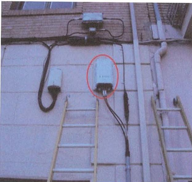
Ilustración 3: Caja terminal óptica (CTO) exterior
