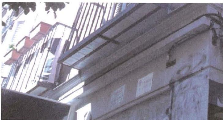
Ilustración 1a: Instalación de cable por fachada
