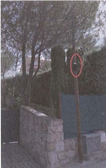
Ilustración 4: Caja terminal óptica (CTO) instalada en Poste
