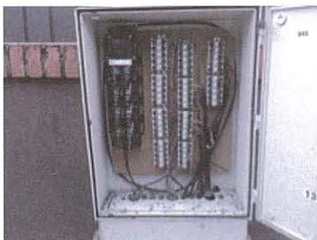
Ilustración 5: Caja terminal óptica (CTO) instalada en Pedestal
