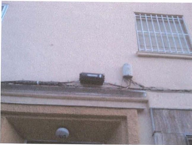
Ilustración 2: Caja terminal óptica (CTO) exterior
