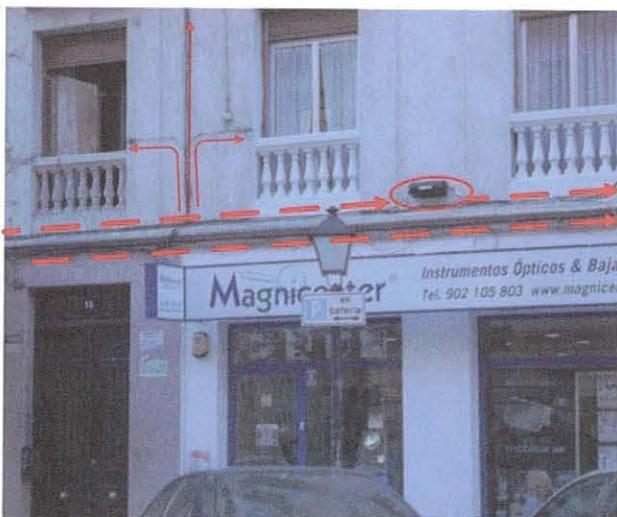
Ilustración 1b: Instalación de cable por fachada
