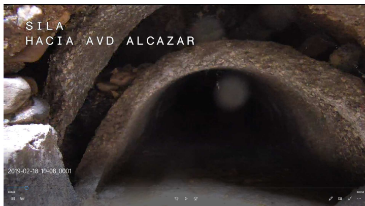
Tubo desplazado en pozo
