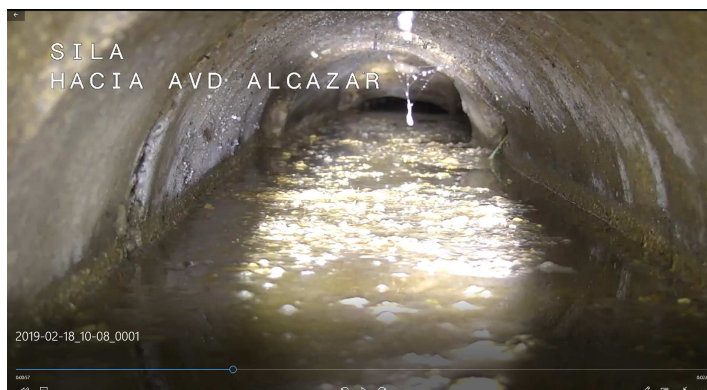
Tubos desplazados y hundimiento de colector. Falta de pendiente
