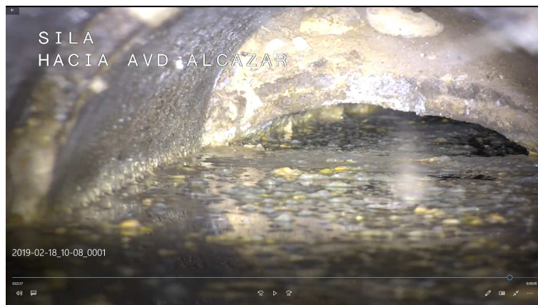
Colapso del colector por hundimiento
