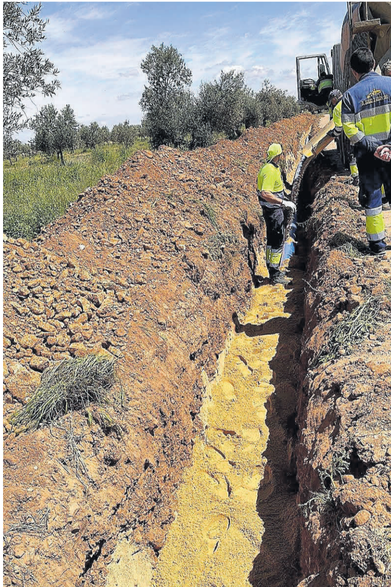
Los operarios canalizan el pozo de 'La Lobera' con la red de abastecimiento.
