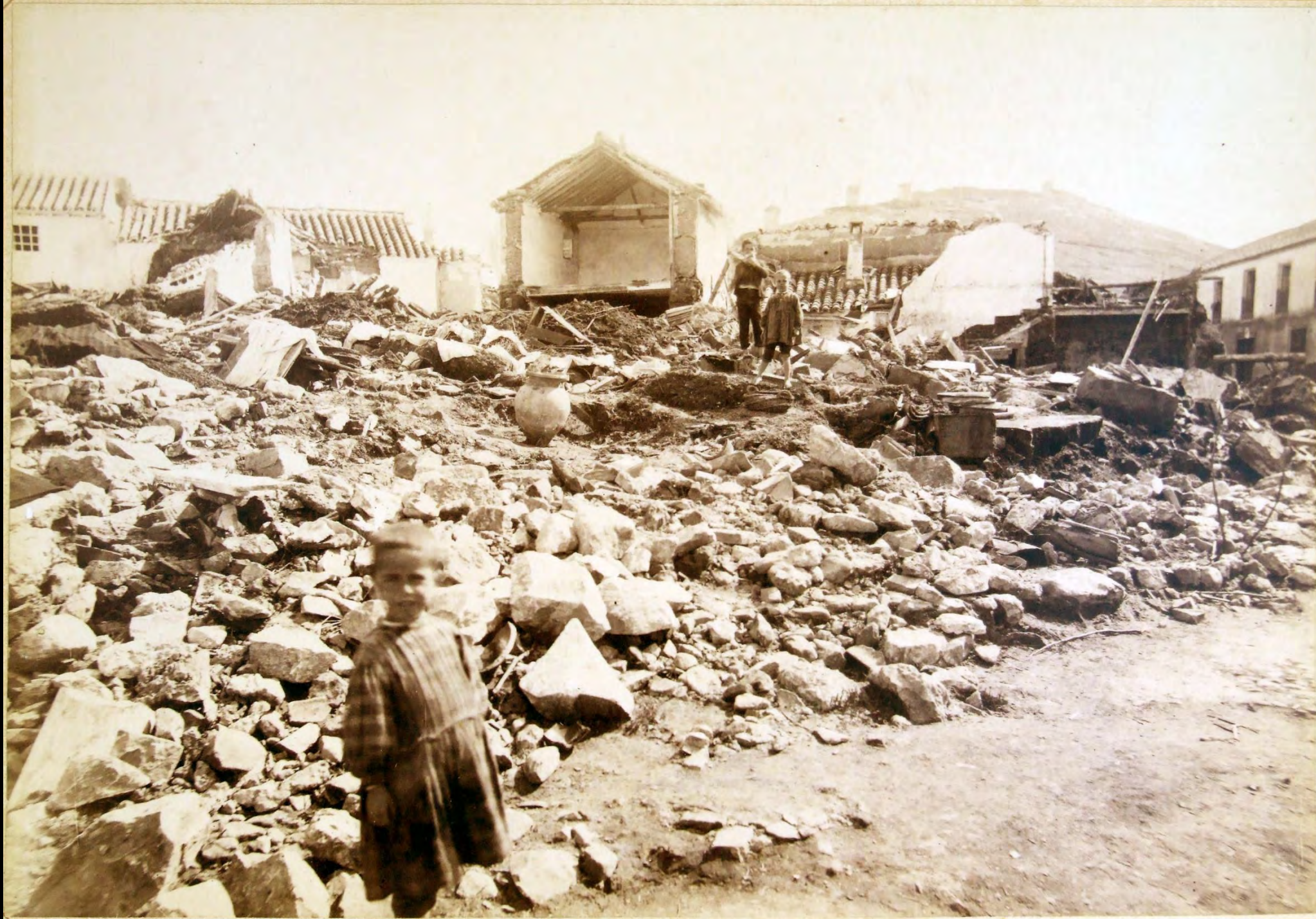
Niños entre los escombros
