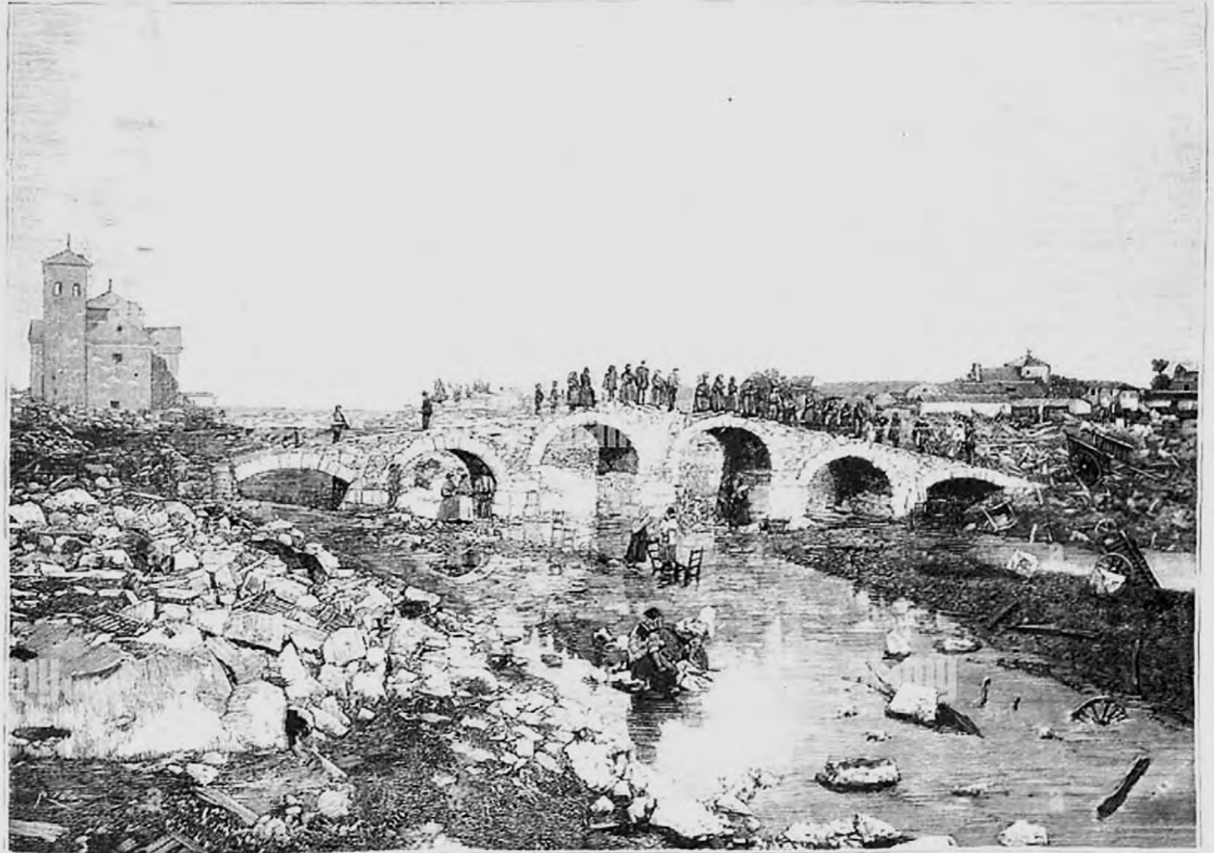
PUENTE DE LA CALLE DE URDA Y ORILLAS DEL AMARGUILLO, DESPUÉS DE LA AVENIDA DEL 11 DEL ACTUAL.
