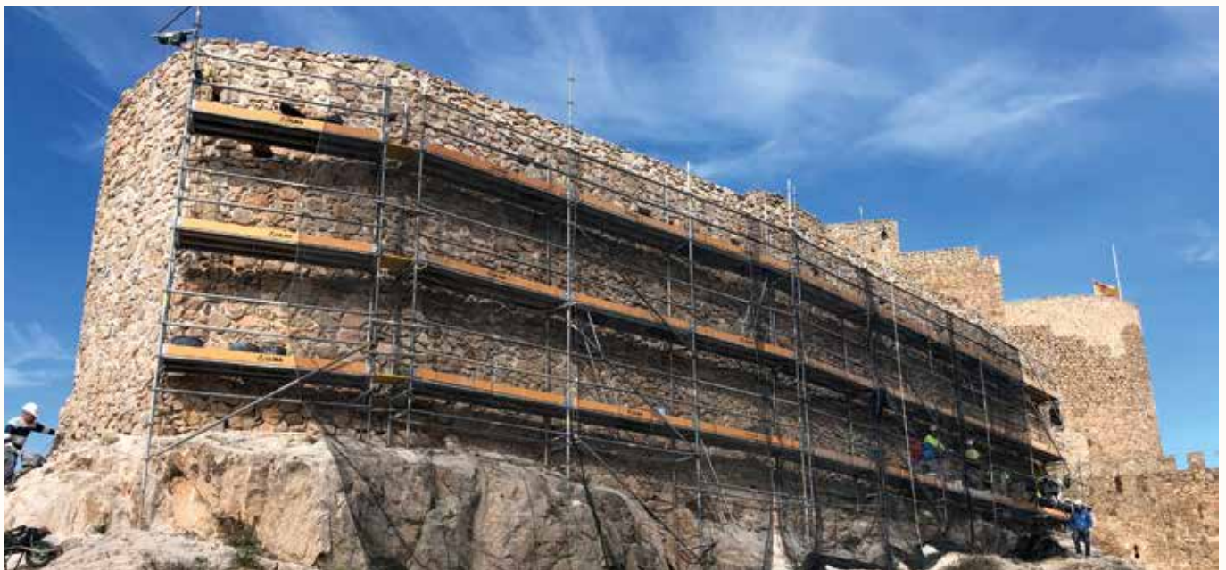
Trabajos de consolidación en fábricas exteriores del tercer recinto amurallado
