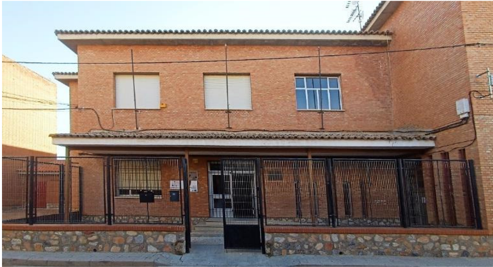
Exterior, fachada suroeste (calle Reyes Católicos)
