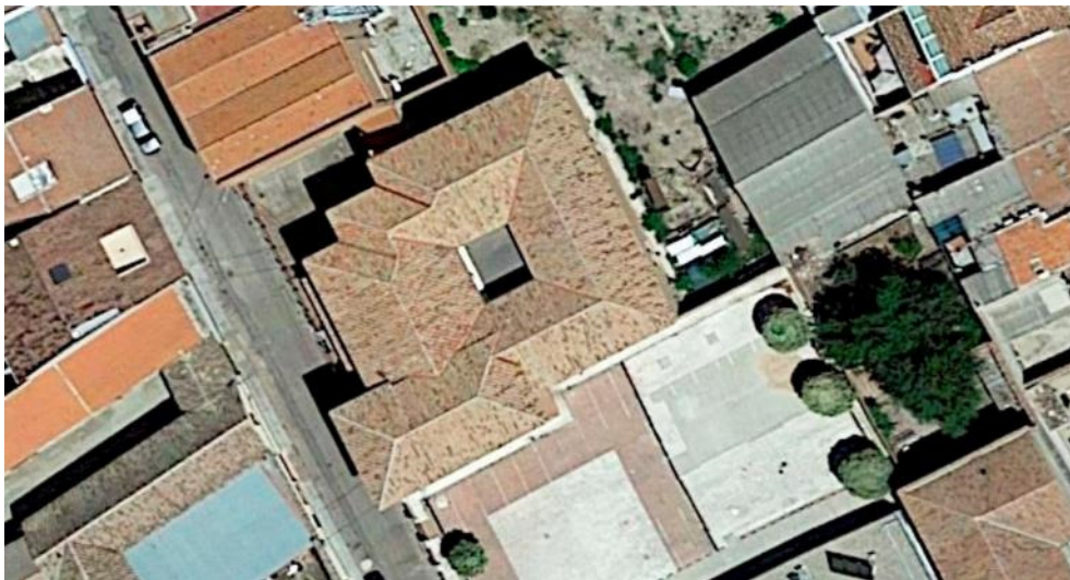
Cubierta edificio y entorno
