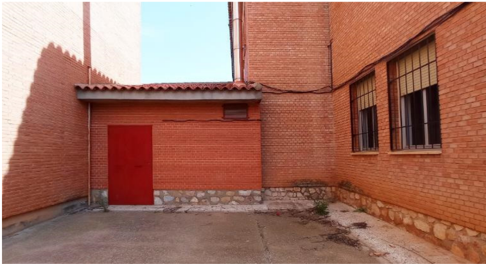
Exterior, cuarto de instalaciones (acceso)
