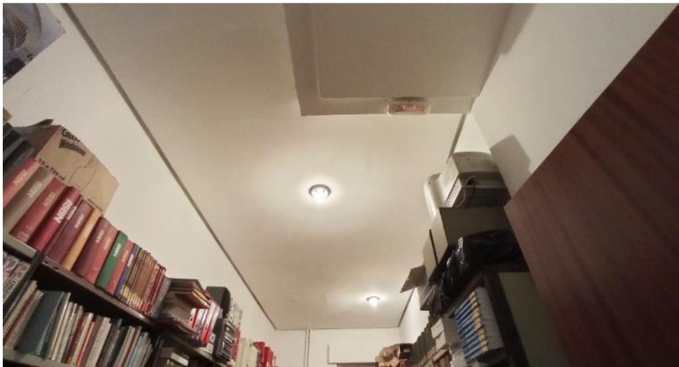
Interior planta baja, depósito
