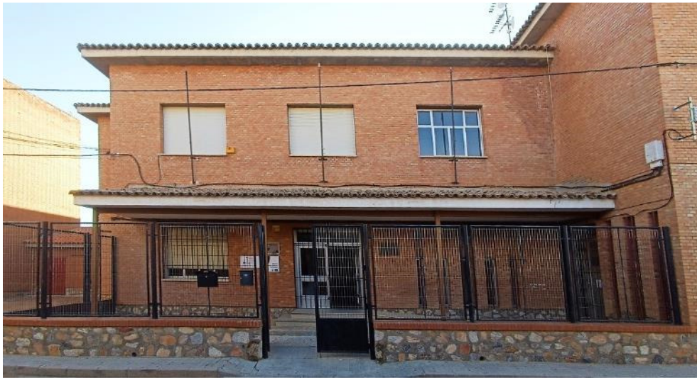
Exterior, fachada suroeste (calle Reyes Católicos)
