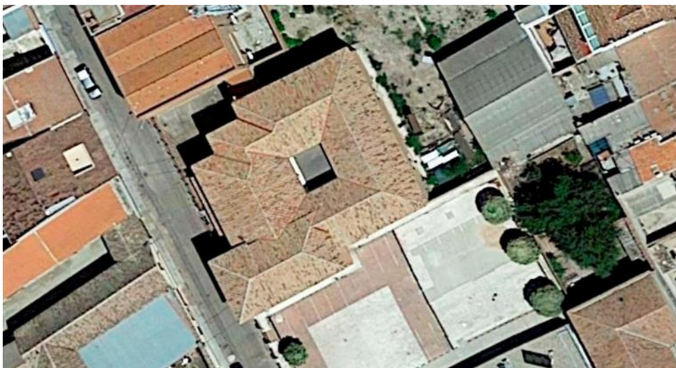
Cubierta edificio y entorno
