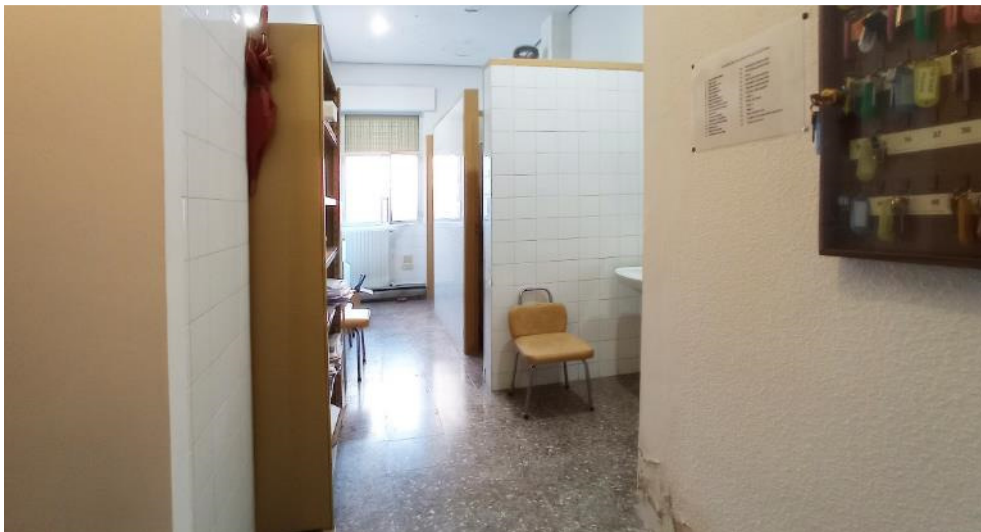
Interior planta baja, aseos
