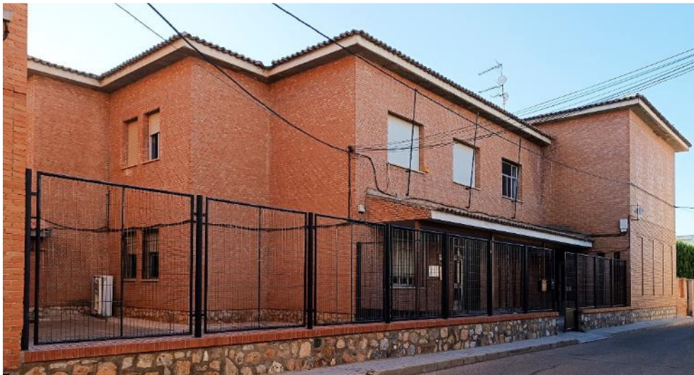
Exterior, vista norte
