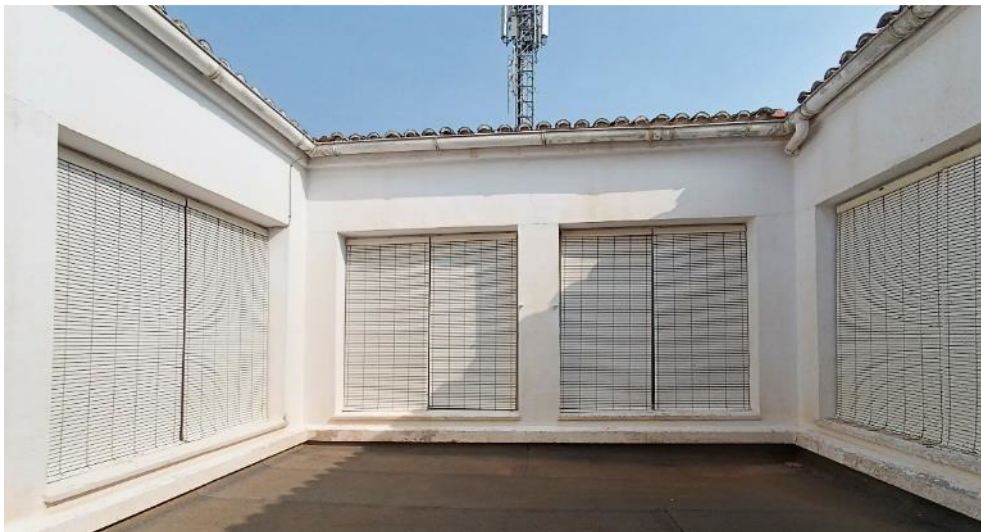
Exterior planta primera, patio interior
