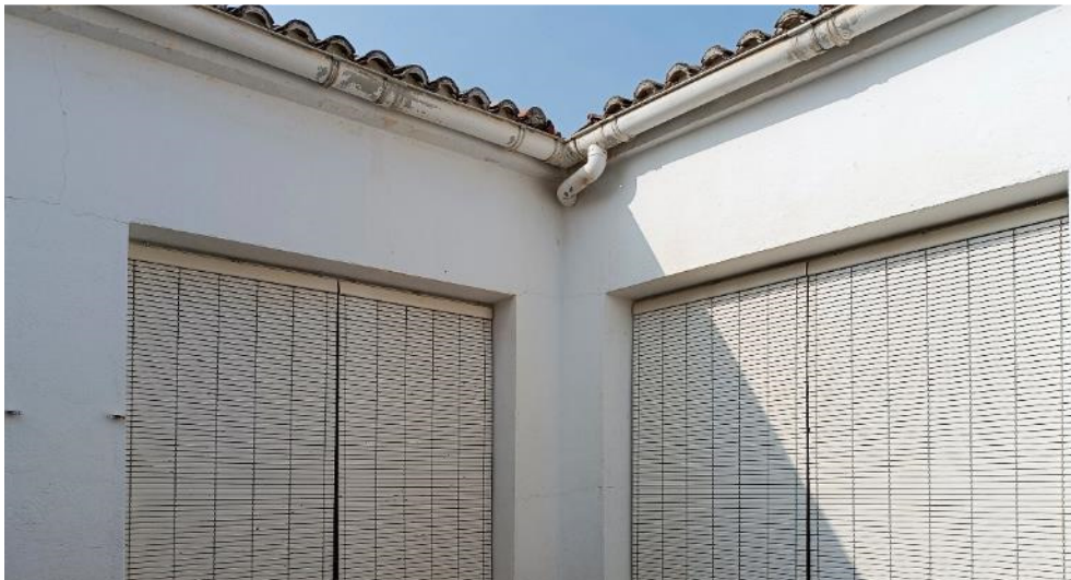
Exterior planta primera, patio interior
