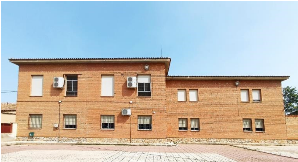
Exterior, fachada sur.
