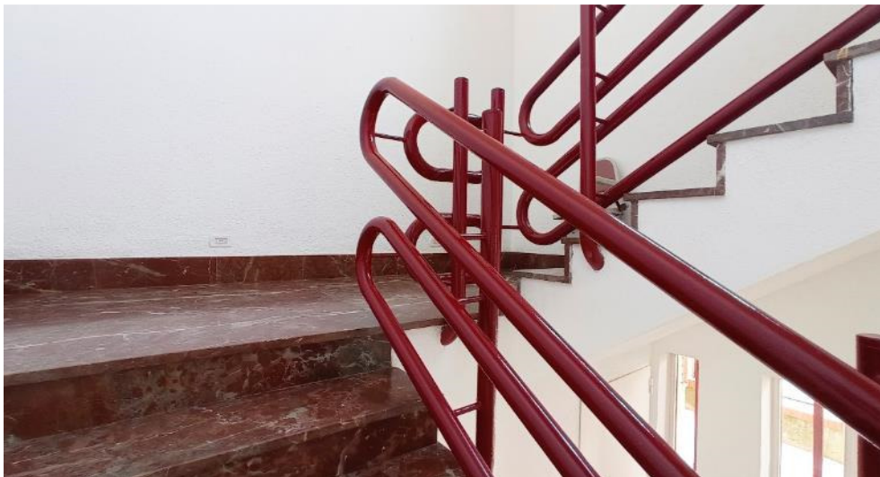
Interior planta baja, escalera
