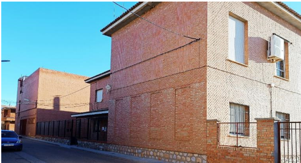
Exterior, vista sur
