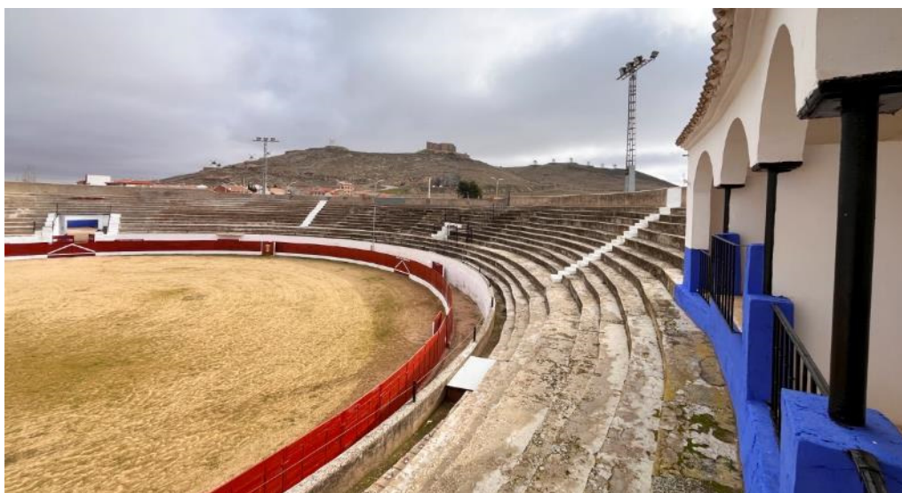
Vista general desde acceso suroeste
