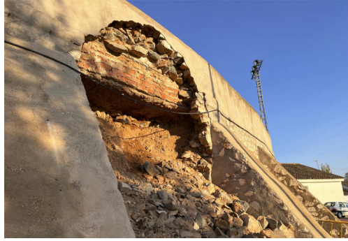
Detalle fábrica mampostería con rellenos interiores y solera superior
