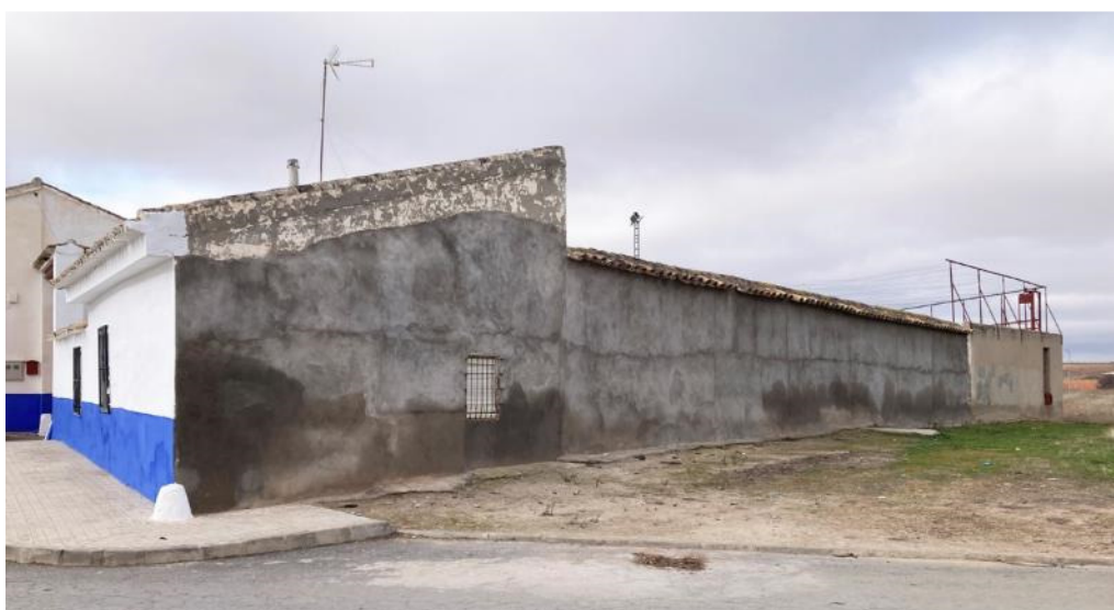
Exterior, lateral noreste - corrales
