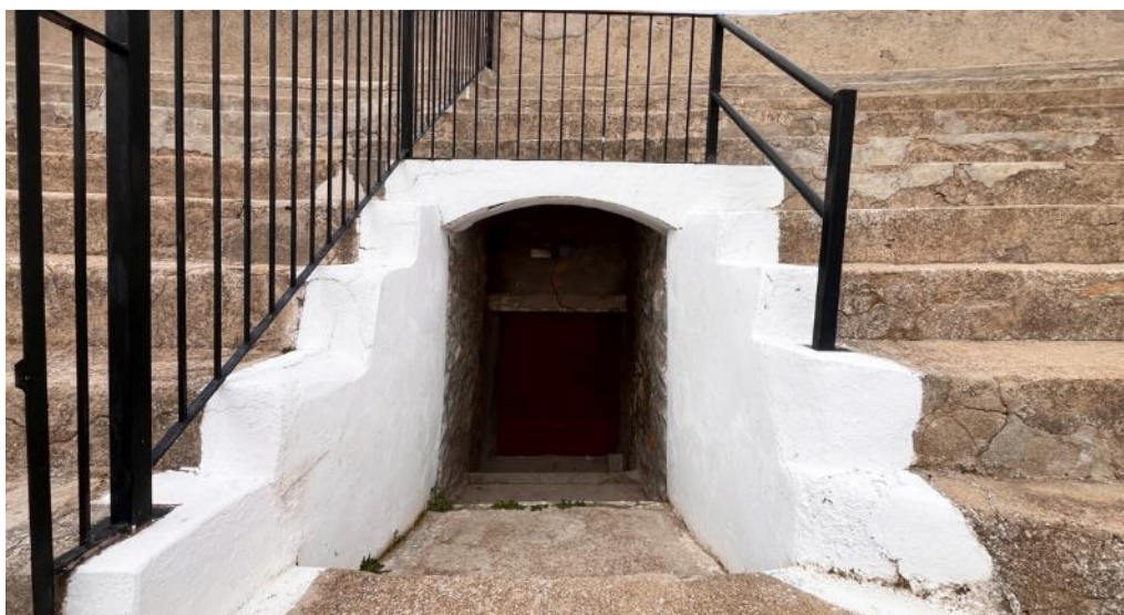
Acceso noroeste (sol)
