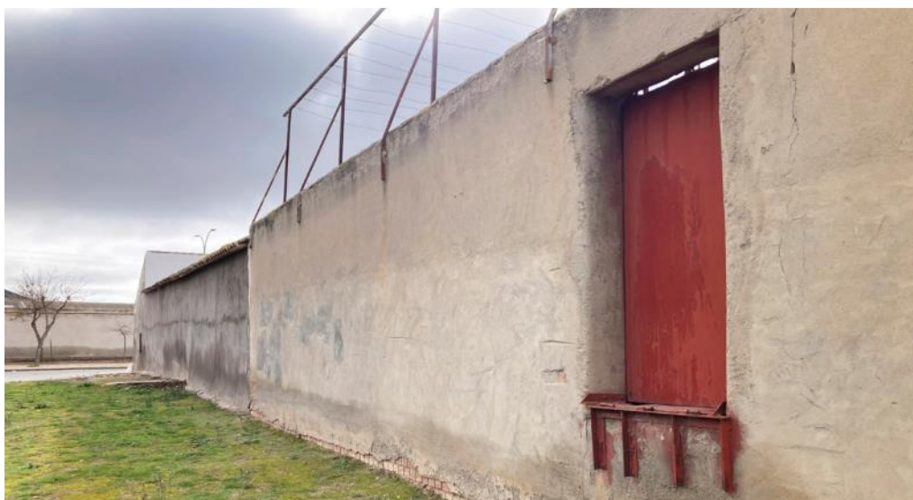
Exterior, acceso ganadería a corrales
