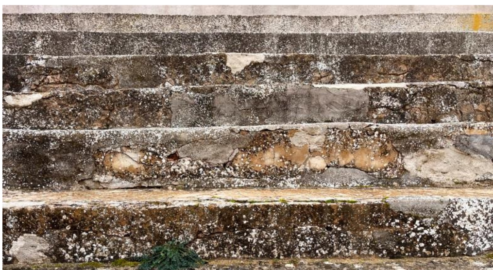
Irregularidades y parcheado de gradas en tendidos
