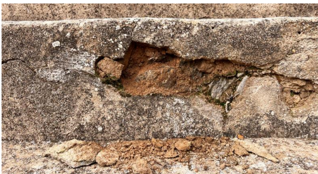
Irregularidades y parcheado de gradas en tendidos
