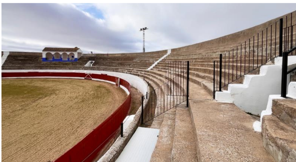
Vista general desde acceso noroeste
