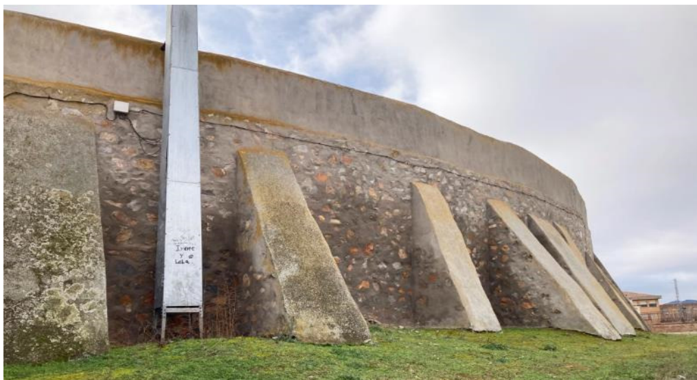
Exterior, cerramiento norte
