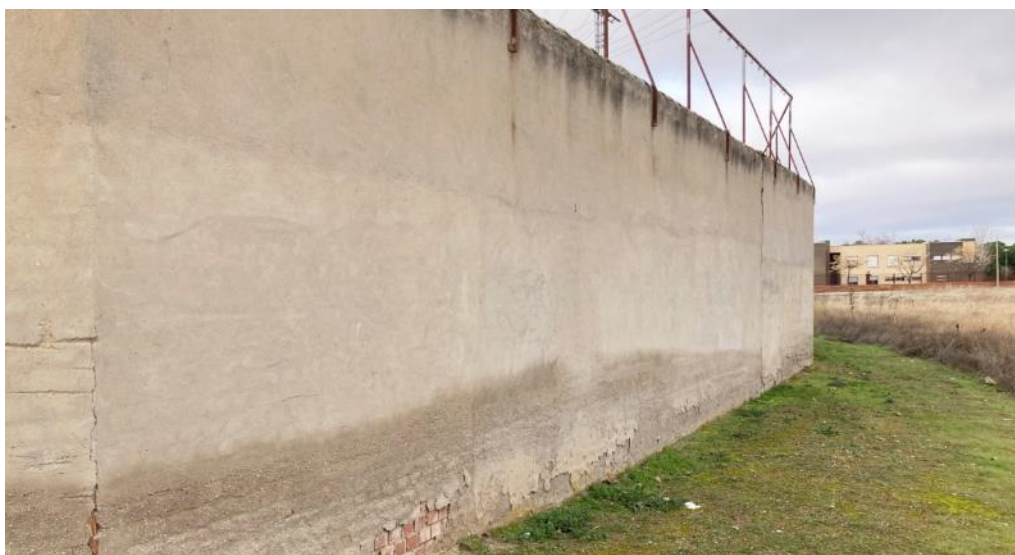
Exterior, cerramiento corrales
