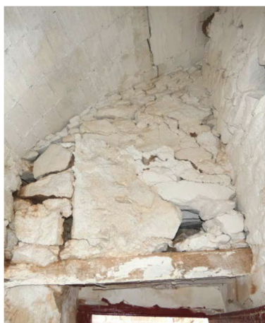
ausencia de mortero en junta y falta de cohesión mampostería en zona de taquillas
