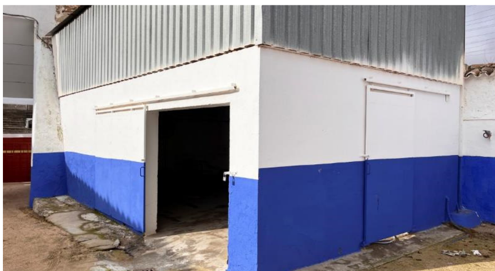
Construcciones auxiliares – nave de despiece
