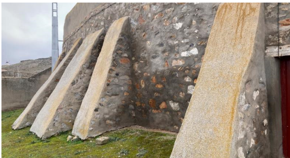
Exterior cerramiento norte
