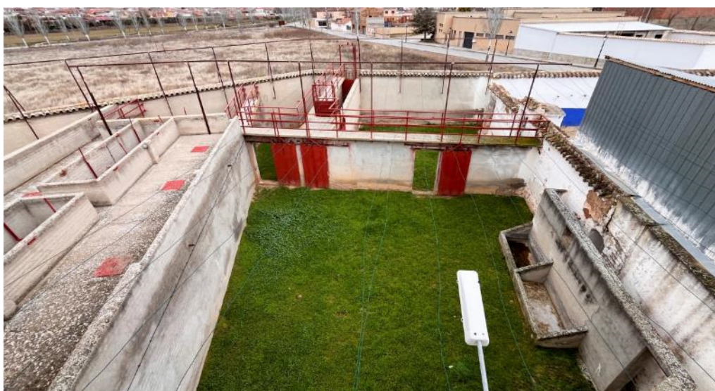
Construcciones auxiliares – toriles y pasarelas
