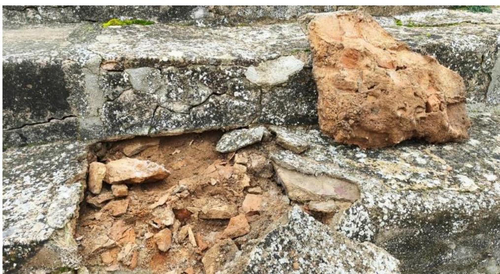
Irregularidades y parcheado de gradas en tendidos
