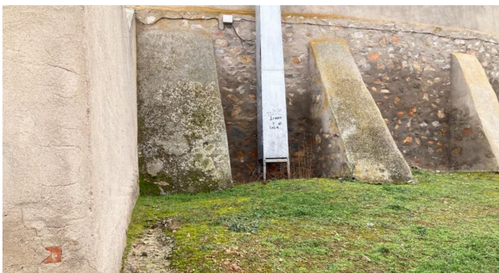
Exterior, cerramiento norte
