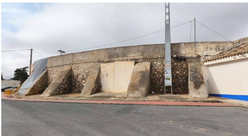
Perímetro exterior, cerramiento sureste
