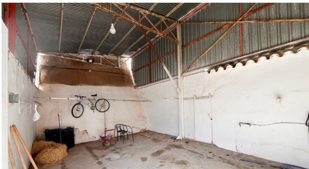
Construcciones auxiliares – nave de despiece
