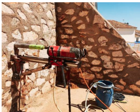
trabajos de campo: escaneo por nube de puntos / perforaciones en muro y ensayos de penetración dinámica
