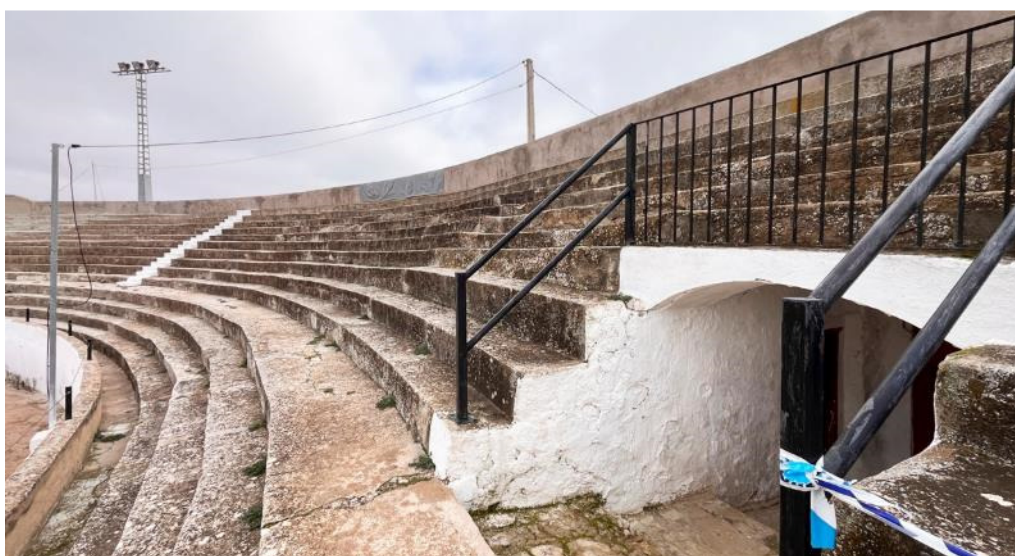
Acceso a tendidos desde puerta sureste
