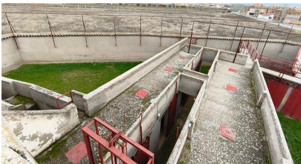
Construcciones auxiliares – toriles y pasarelas
