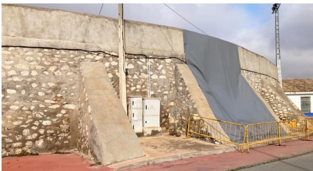
Exterior, cerramiento sureste
