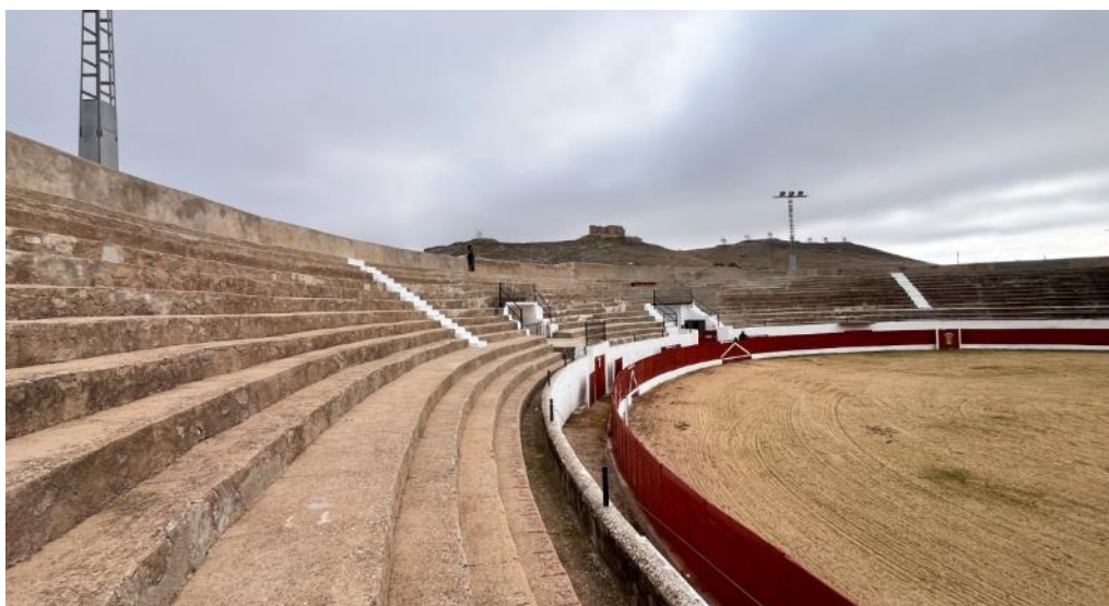
Vista general desde acceso noroeste
