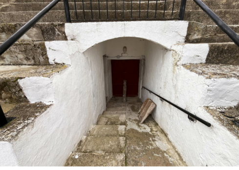
Acceso suroeste - tendido sombra
