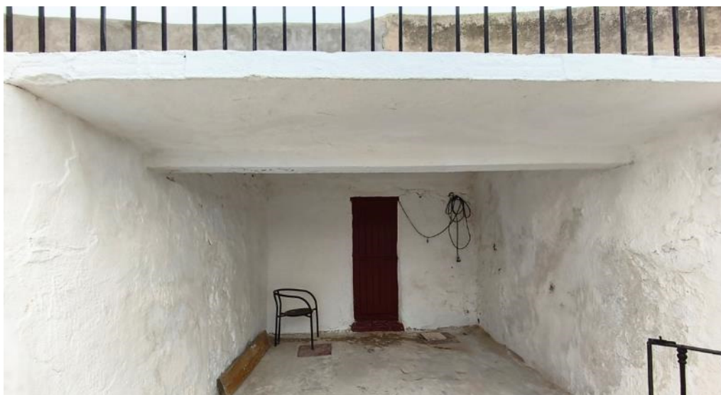
Platea sobre toriles y acceso a pasarelas exteriores
