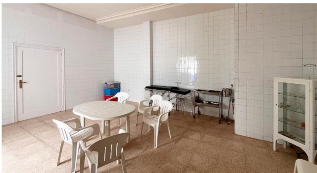
Construcciones auxiliares – enfermería
