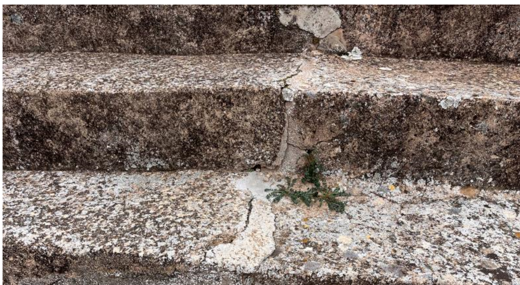
Irregularidades y parcheado de gradas en tendidos
