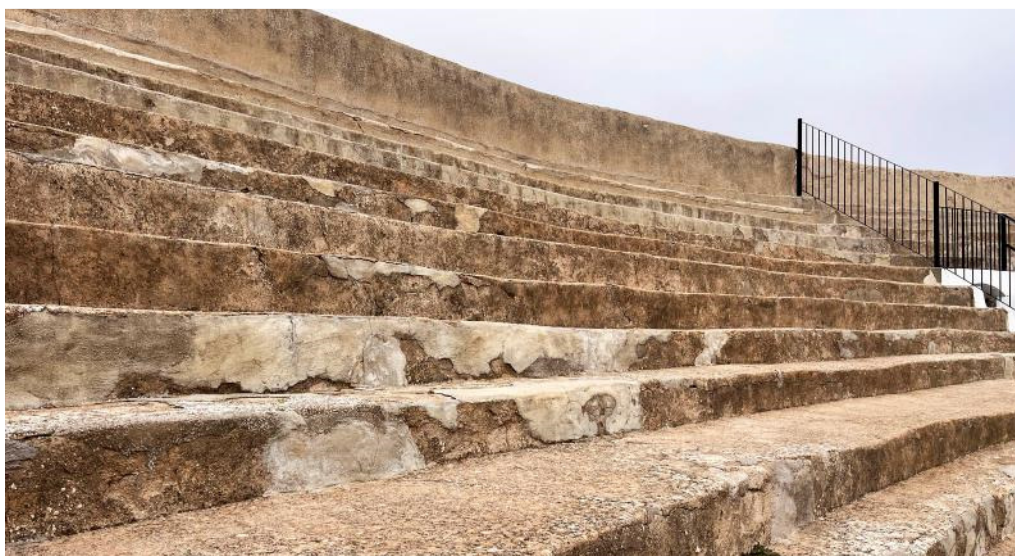
Irregularidades y parcheado de gradas en tendidos
