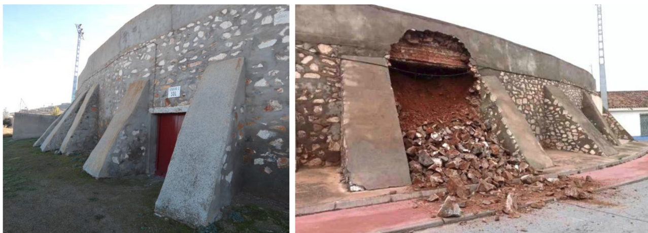
cerramiento exterior y contrafuertes – paños noroeste y sureste
