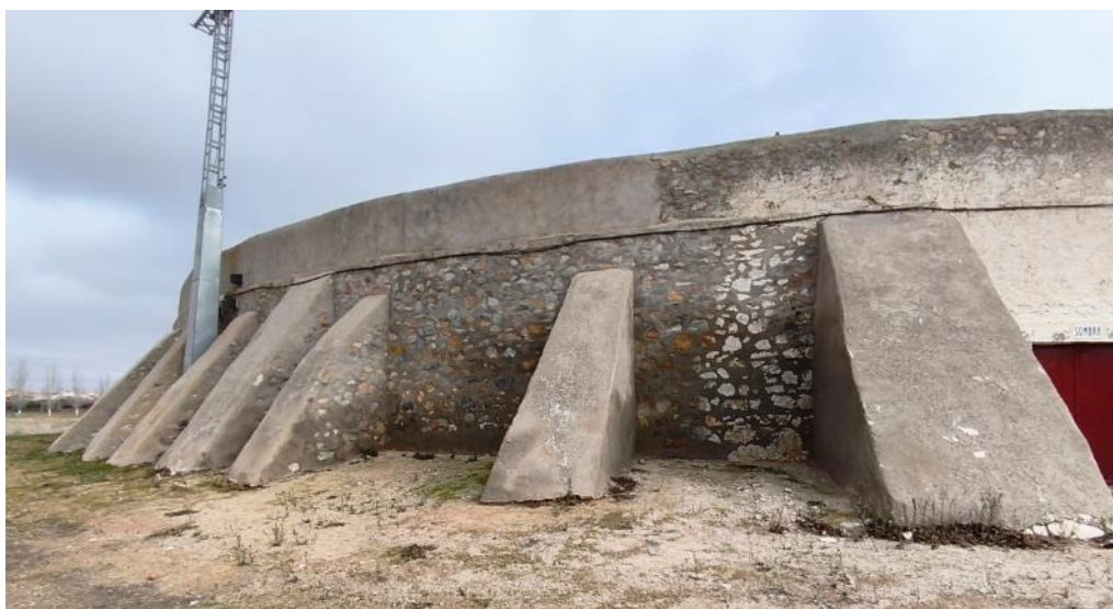
Exterior, acceso suroeste (sombra)
