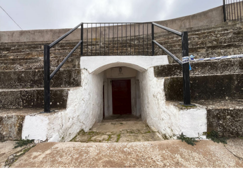
Acceso sureste - tendido sol y taquillas laterales bajo gradas
