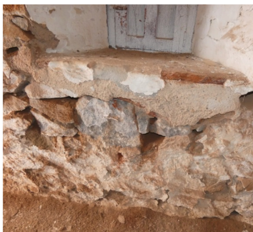
ausencia de mortero en junta y falta de cohesión mampostería en zona de taquillas
