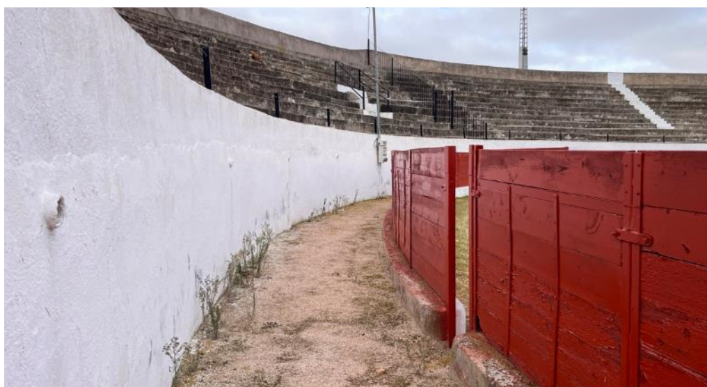
Callejón perimetral – detalle aliviaderos
