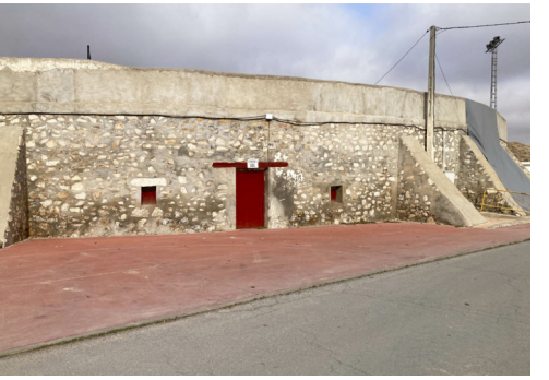
Ista general exterior sureste - acceso tendido sol y taquillas
