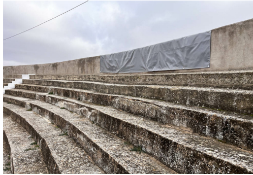
Vista general graderío tendido sol sureste
