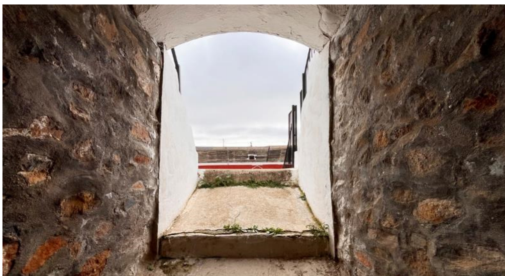
Acceso noroeste (sol)
