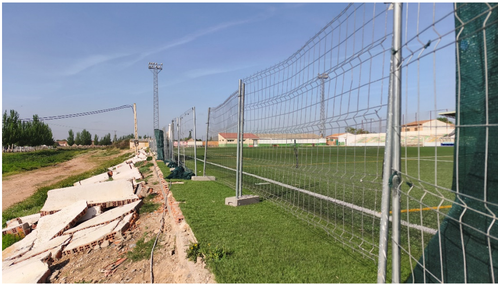
Estado actual cerramiento sureste
