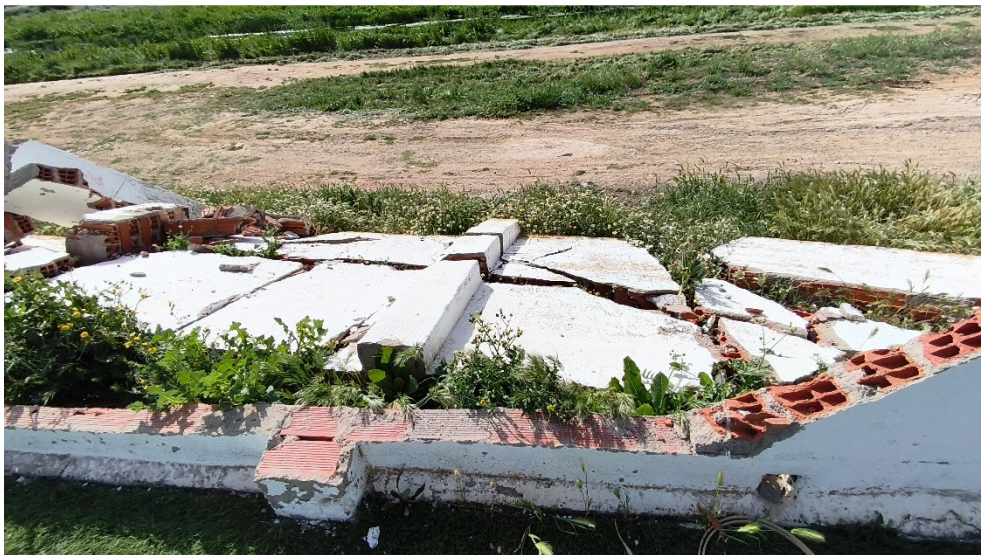
Restos de fábrica de ladrillo tras el derrumbe del anterior cerramiento
