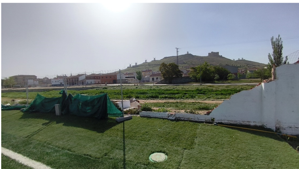
Vista general del cerramiento desde el interior
