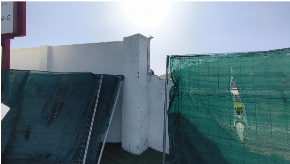
Mocheta de inicio de cerramiento proyectado (esquina este)
