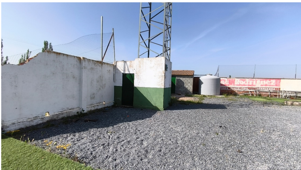
Zona sur de acceso a obra y acopio de materiales
